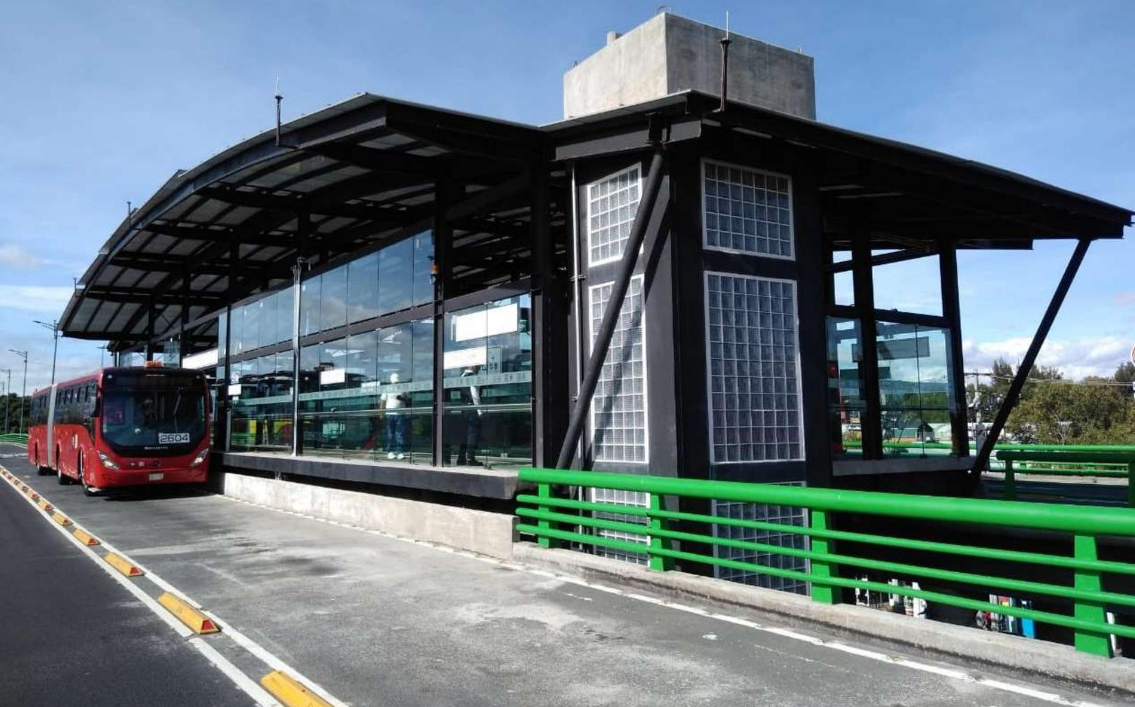
**Estaciones La Joya y El Caminero del corredor Insurgentes, la Estación Félix Cuevas de la Línea 1 de Metrobús, la Estación Tacubaya de Línea 2 y mantenimiento del corredor Reforma.** En la estación El Caminero se realizaron trabajos de ampliación de un cuerpo paralelo, modificando la estación para incluir un segundo acoplamiento y la rehabilitación de dos cruces seguros.
