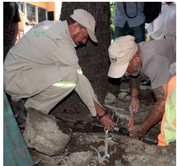
Reparación de fugas de agua
