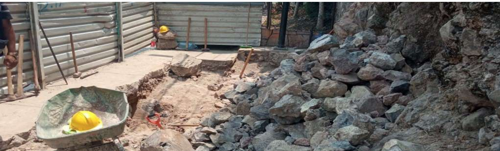
Jardin de niños, rehabilitación barda
