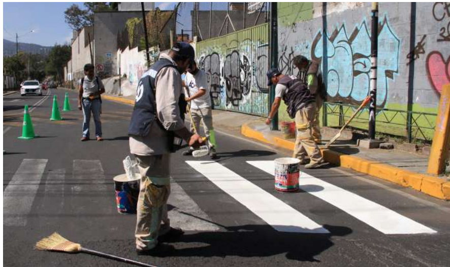
Trabajos de pintura y mantenimiento
