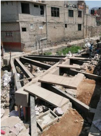
Mitigación de riesgos, puente Cuauhtepac
