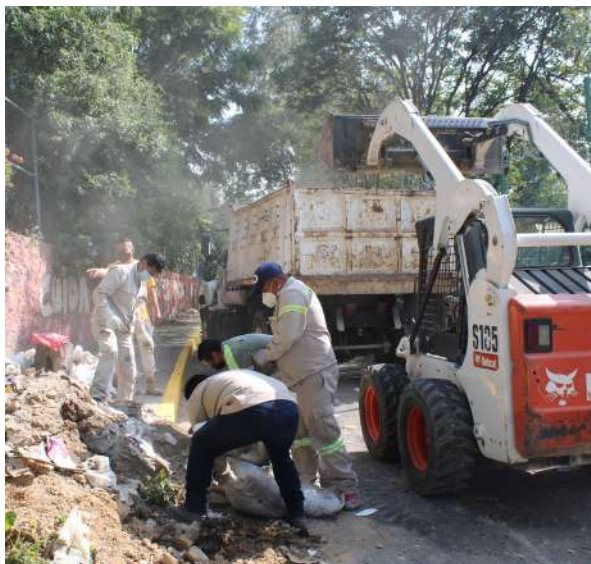
Rehabilitación de banquetas y guarniciones
