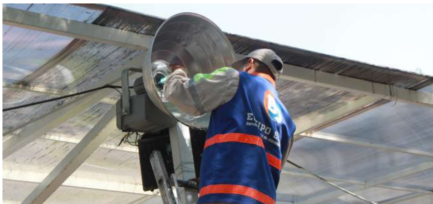
Cambio de luminaria pública
