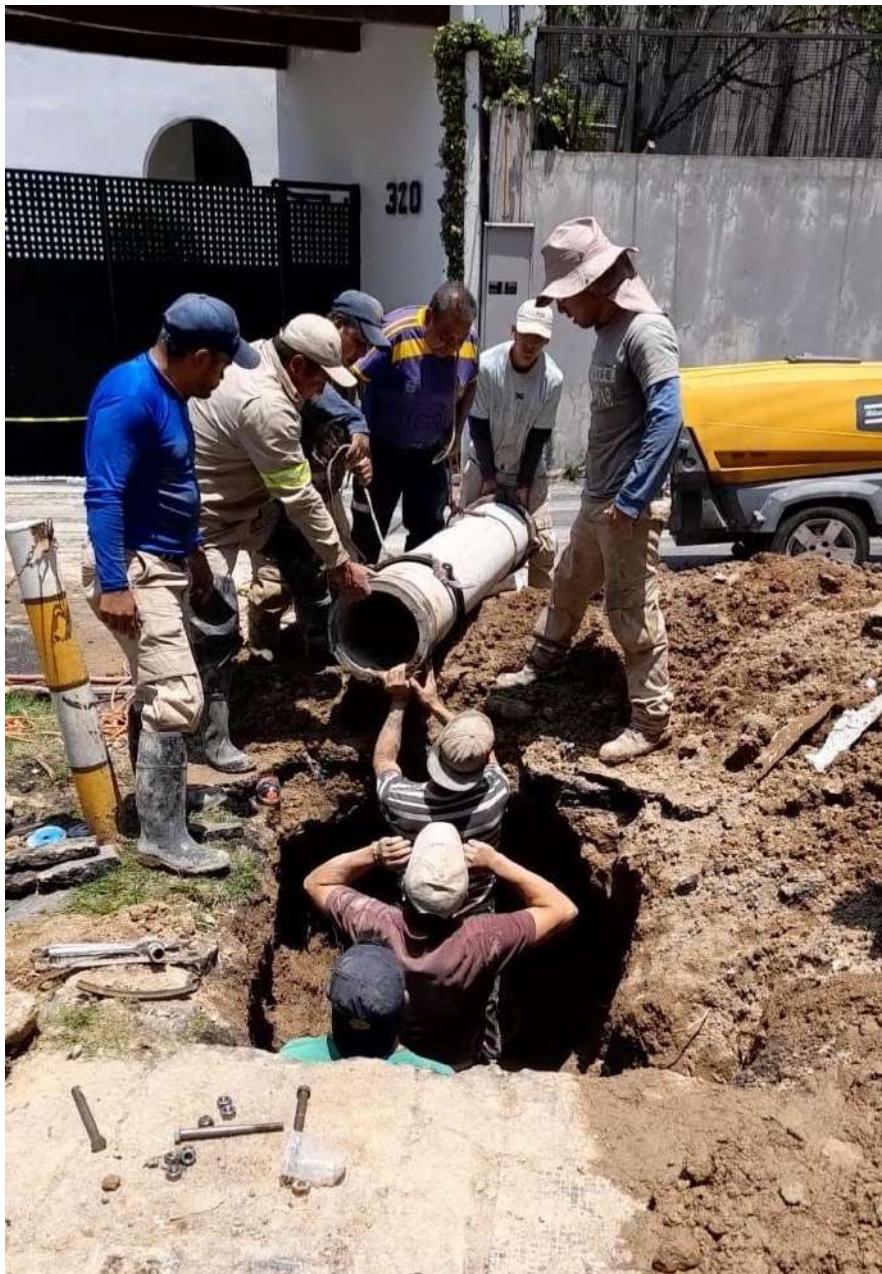
Agua potable, cambio de tubería
